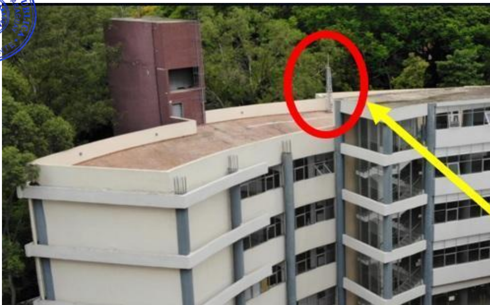
Fig. 7 Ubicación de la Torre para antenas de enlace y equipos de comunicaciones en el laboratorio de la AEP-UNA, sitio de la futura Estación Terrena AEP-UNA
